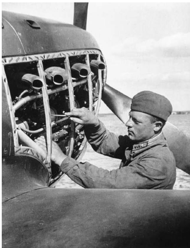
*Механик налаживает мотор М-105П истребителя Як-1 из 11-го иап на аэродроме Кубинка*
