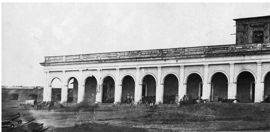
Центральная таможня и казематная береговая батарея, построенные в Асунсьоне при Карлосе Антонио Лопесе.
